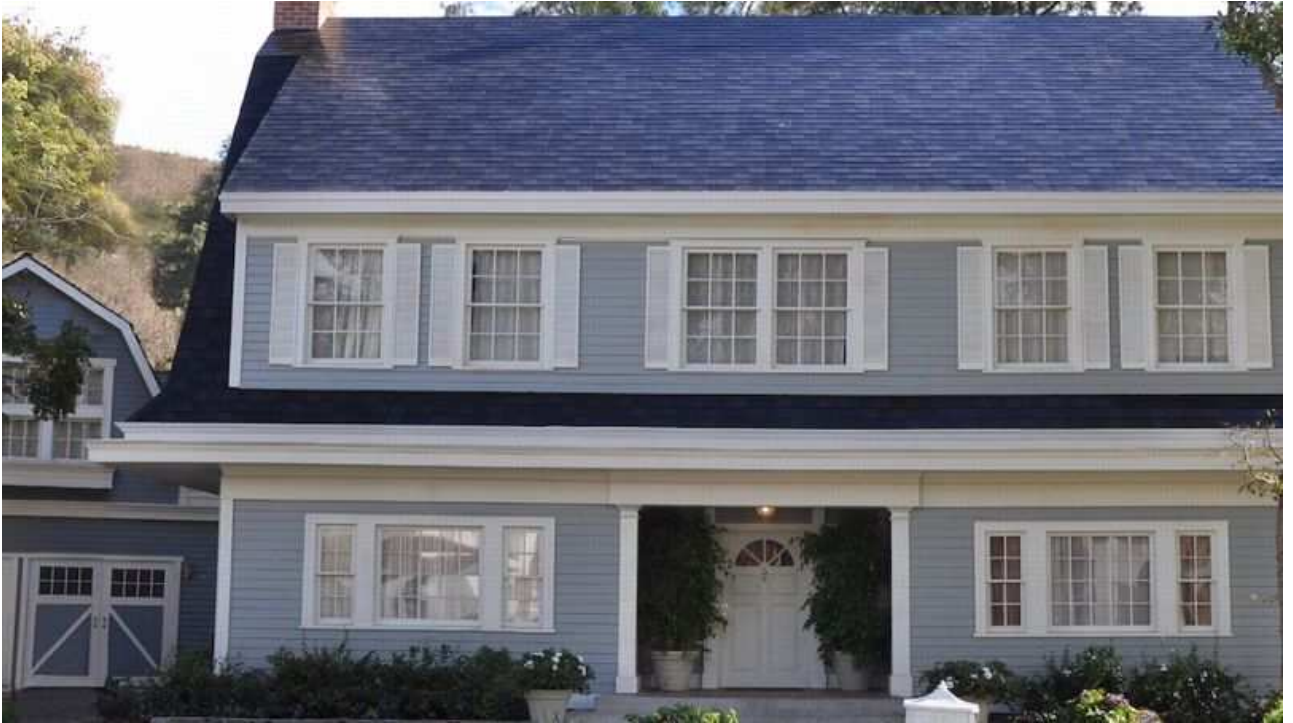
Cherchez les panneaux photovoltaïques sur ce toit, ils y sont bel et bien. Crédit: Tesla
