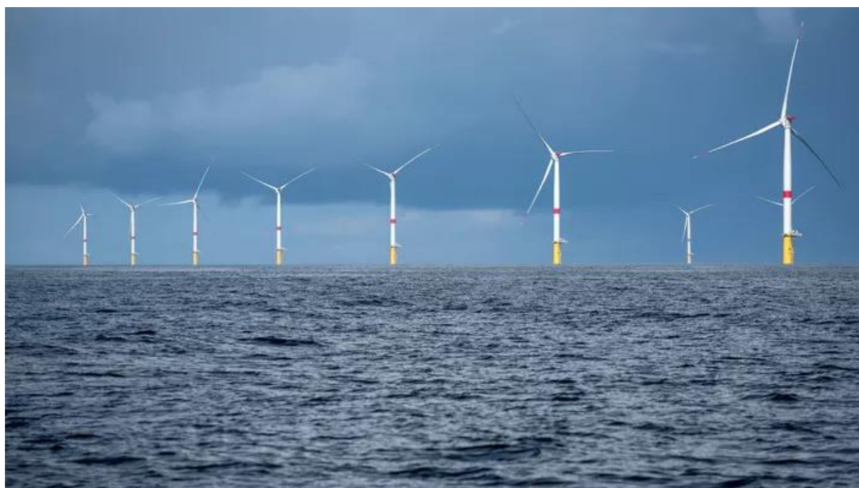
Parc éolien en mer de Saint-Nazaire EDF Renouvelables
