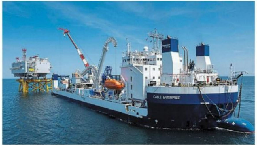
Pour réaliser le raccordement en mer, 150 personnes ainsi que six grands navires de travail, dont un navire câblé, ont été mobilisés en juin 2023.
