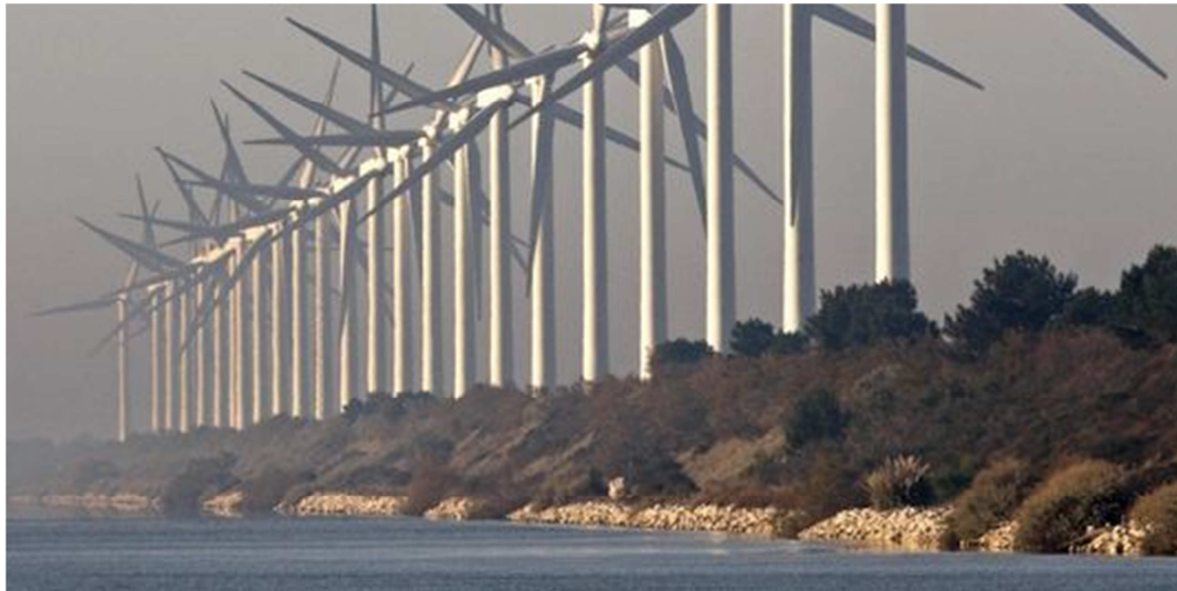
Fermes d'éoliennes, dans la région de Marseille
