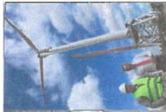
Une grue de 160 m, près de l'éolienne.
